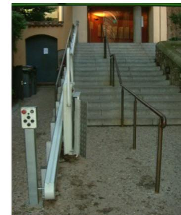
*Création de deux types d'élévateurs pour Personnes à Mobilité Réduite : un élévateur vertical (à gauche) est généralement préféré à un élévateur oblique (à droite) pour des raisons de sécurité, de confort et d'esthétique.*
